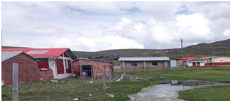
Imagen 2.- En la temporada de máximas avenidas, la quebrada riachuelo huaycco se desborda en este tramo afectando viviendas, criadero de cuyes y otros.
