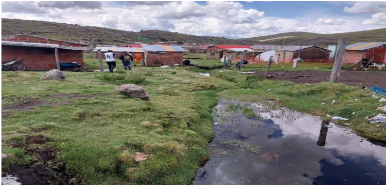
Imagen1.- Se observa estancamiento de agua en el cauce debido a la baja pendiente y reducción de la sección hidráulica.
